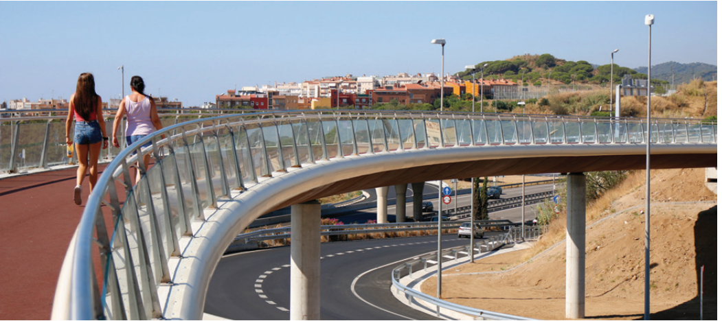
El nus viari de Mataró Oest segueix en obres
